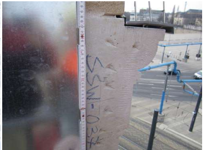
Bohrlöcher Cottaer Stein
