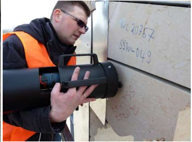
Bohrwiderstandsgerät TERSIS 2 im Einsatz
