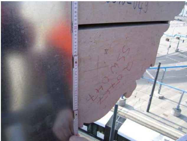
Bild 2 Bohrlöcher Reinhardtsdorfer Stein
