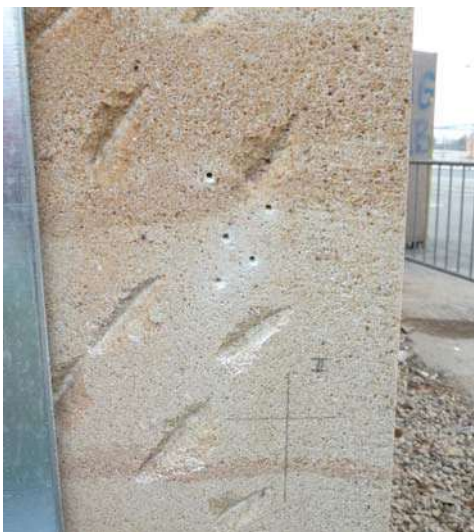
Bild 3 Bohrlöcher Sandstein Alte Poste
