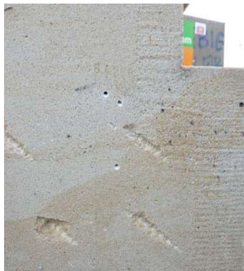
Bohrlöcher Mühlleitner Sandstein
